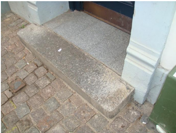
Sætning af indgangstrin samt belægning
