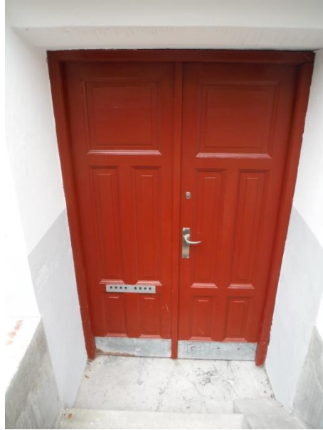
Renoveret dør til kælder
