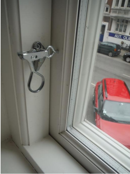
Nye, koblede vinduer
