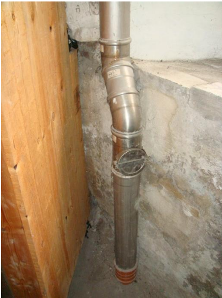
Faldstamme i rustfrit stål fra 1992
