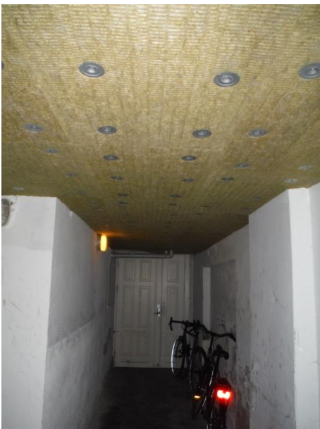
Isoleret etagedæk mod stueetagen
