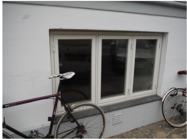
Nye vinduer i kælderen
