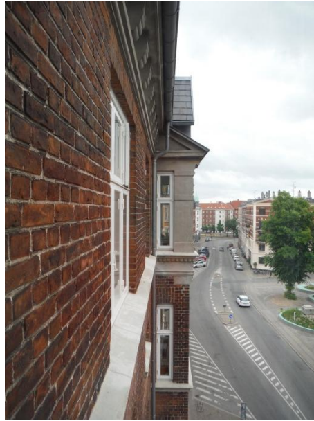
Partielt renoveret overfacade
