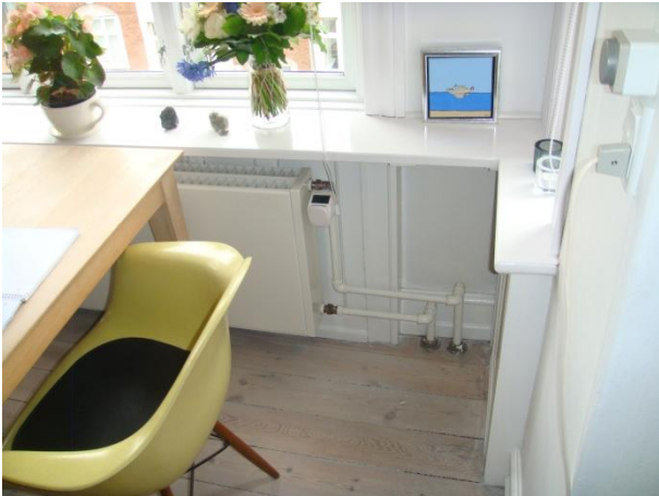
Radiatorer udskiftet i 1996
